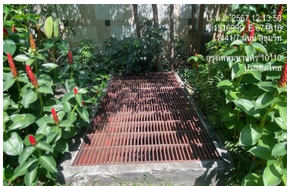
รูปที่ 11 ตะแกรงดักขยะ
